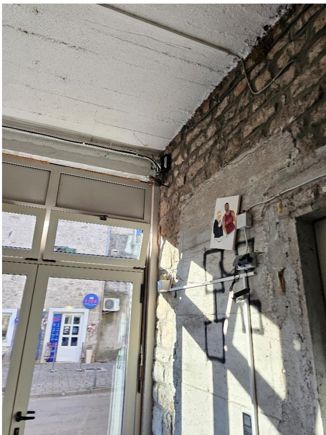
Slika 3: postojeće stanje – vanjska stijenka koja se zadržava i razne instalacije koje se uklanjaju
