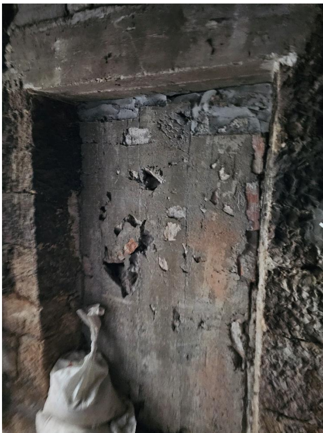
Slika 7: postojeće stanje – oštećeno zid se sanacijski žbuka – niše se zadržavaju
